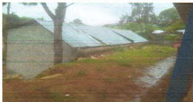
Foto 3: Sustitución de cubierta de lámina de metal.
