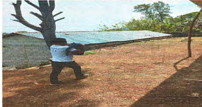
Foto 4: Sustitución de cubierta de lámina de metal.
