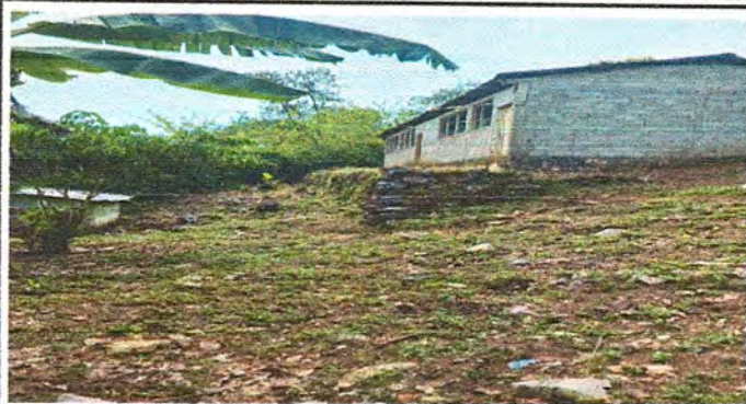
Foto 1: Mantenimiento de muro de contención.
